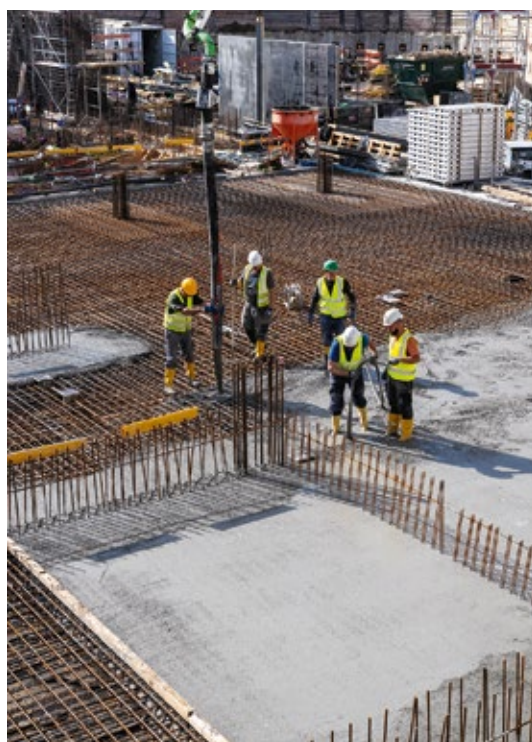
Zur Betonage werden Pumpen von 24 bis 63 Meter Reichweite genutzt.
